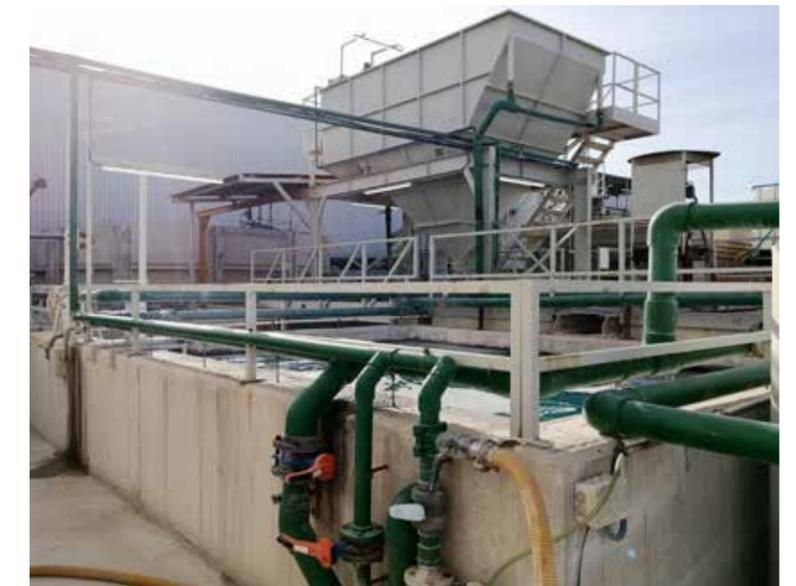
Das Wasser aus den Schleifprozessen zirkuliert in einem geschlossenen Kreislauf, in dem es durch Ablagerung der Schwebstoffe, die in einer Filterpresse konzentriert sind, gereinigt und nachfolgend recycelt wird. Das in den Emailierungslinien eingesetzte Wasser ist ebenfalls aufbereitet. Seine Schadstoffe werden ausgefällt und anschließend als inertes Material der Tonerde beigefügt, aus der die Platten bestehen.
